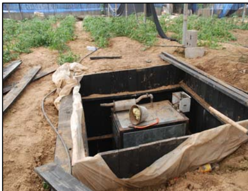
Generator und Ausrüstung zum Graben in der Nähe des Tunnelschafes. Der Generator war im Boden versenkt, um den Lärm zu dämmen und seine Entdeckung zu erschweren (Website des IDF-Sprechers, 16. August).
