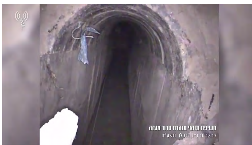
Der terroristische Tunnel der Hamas, der von Khan Junis ins israelische Territorium führte und von der IDF aufgedeckt und neutralisiert wurde (Facebook-Seite des IDF-Sprechers, 10. Dezember 2017)
