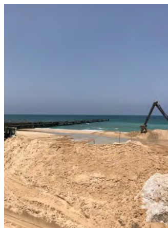
Construction de la barrière navale (page Facebook Shehab, 27 mai 2018)
